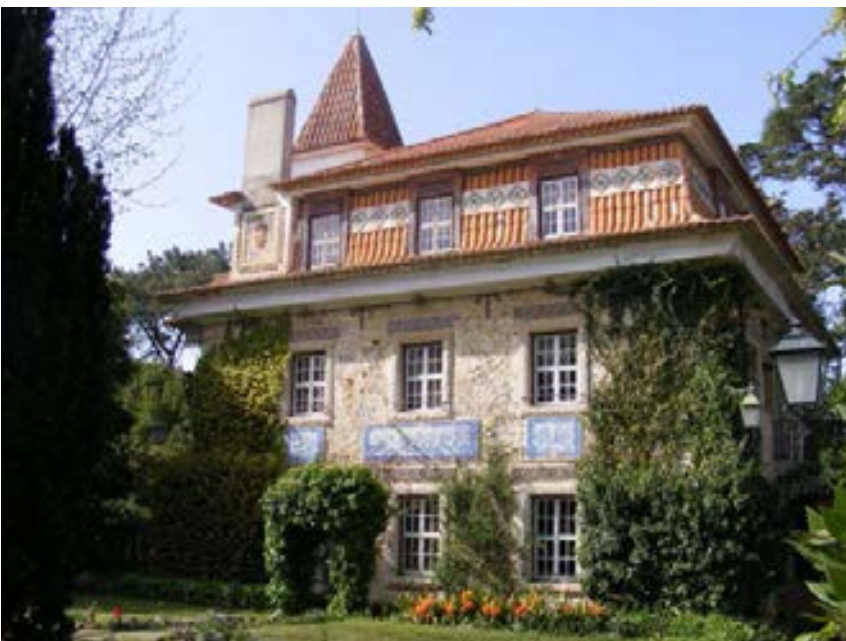
2 - Palacete Visconde de Sacavém. Fachada Sul. Caldas da Rainha
