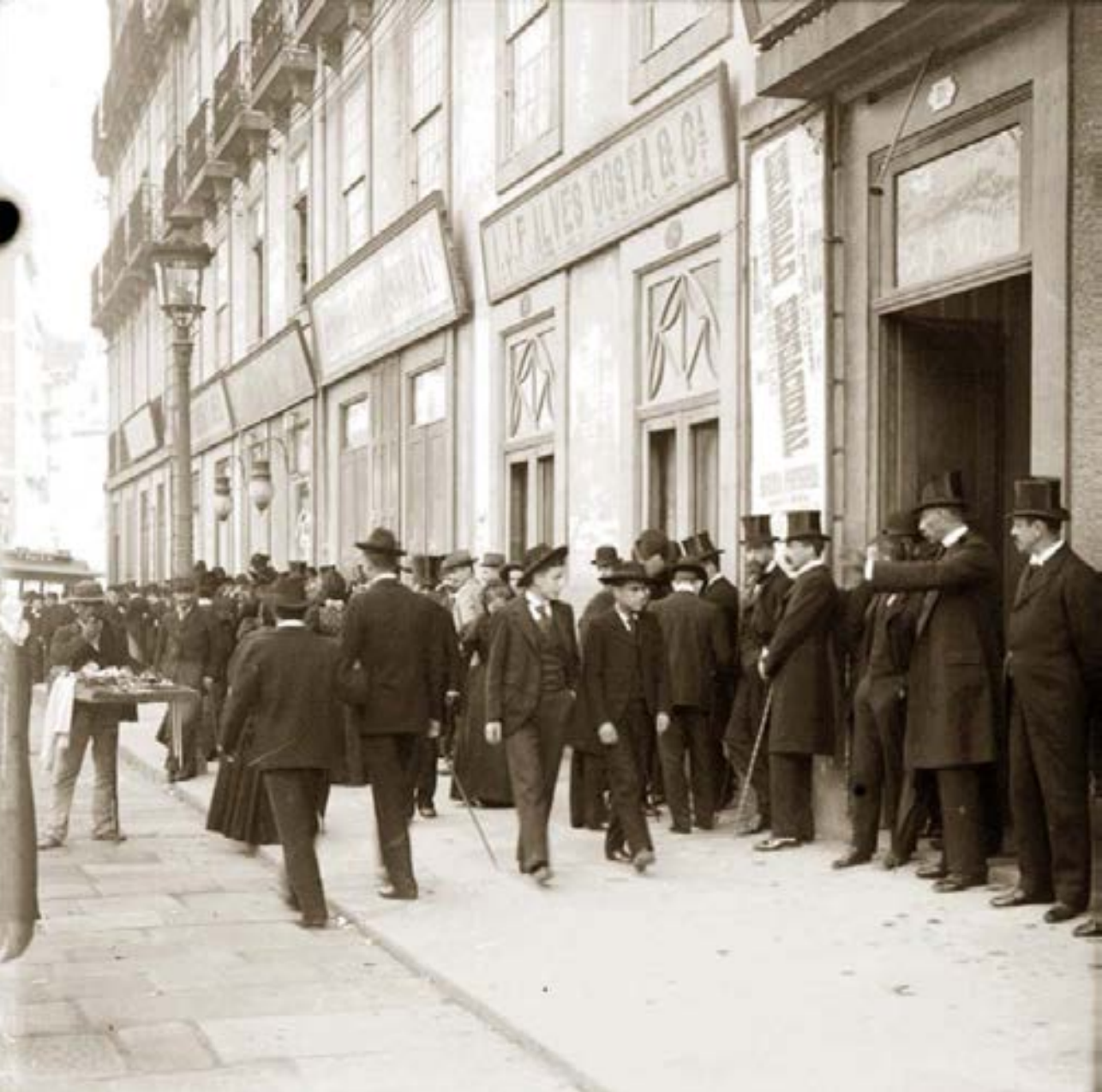
3 – O chamado “Real Club dos Encostados”, “Aquário dos Imbecis” ou “Pasmatório dos Lóios”, o mais afamado pasmatório do Porto do século XIX, fronteiro ao Palácio da Cardosa. Fonte – Cliché de Aurélio Paz dos Reis - O edifício das Cardosas, CPF apr 1162.
