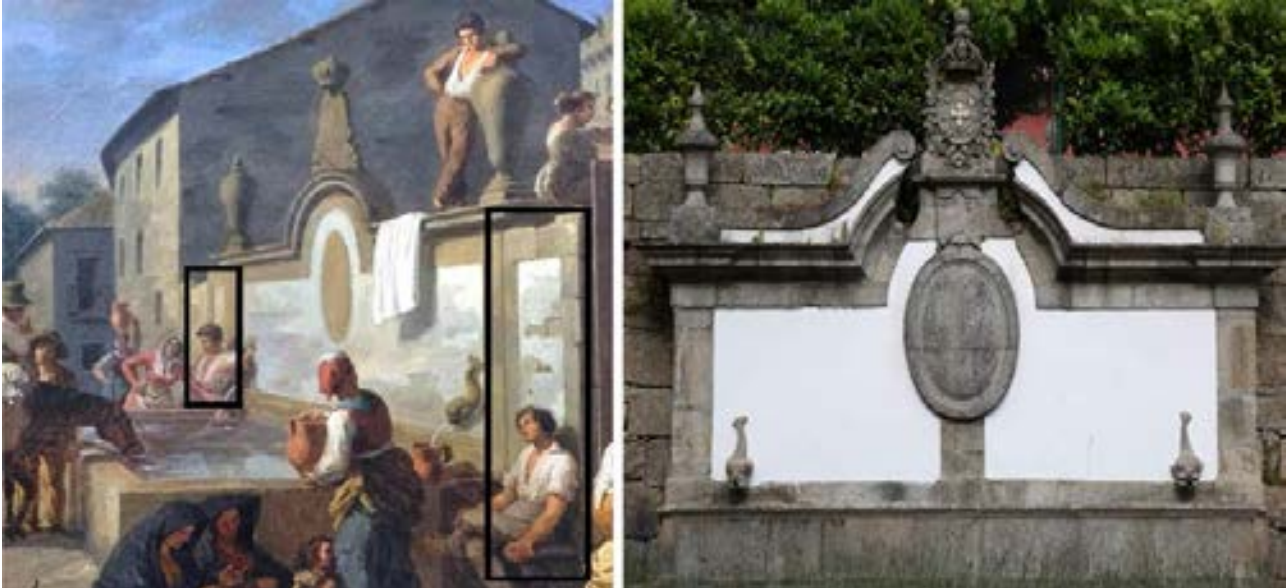
Fig. 28 – Comparação entre o tanque da pintura e o actual, onde se pode ver toda a estrutura e identificar os elementos referidos no texto que permaneceram. Em destaque, na pintura, os dois bancos laterais que desapareceram.
