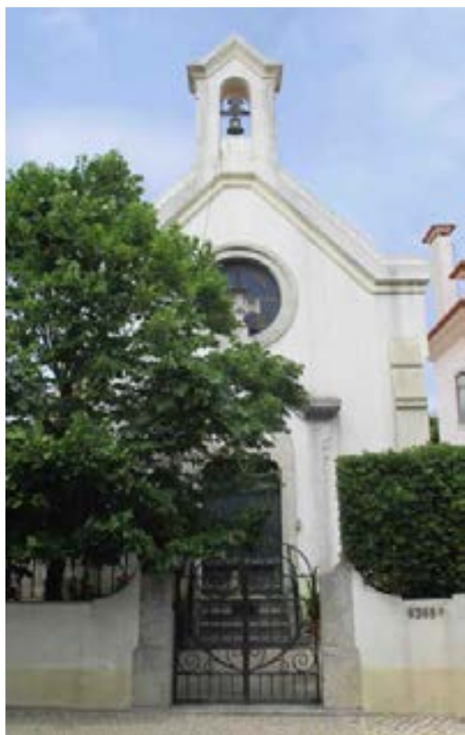
22 – Fachada principal da Capela de Nossa Senhora da Conceição (Fotografia do autor).
