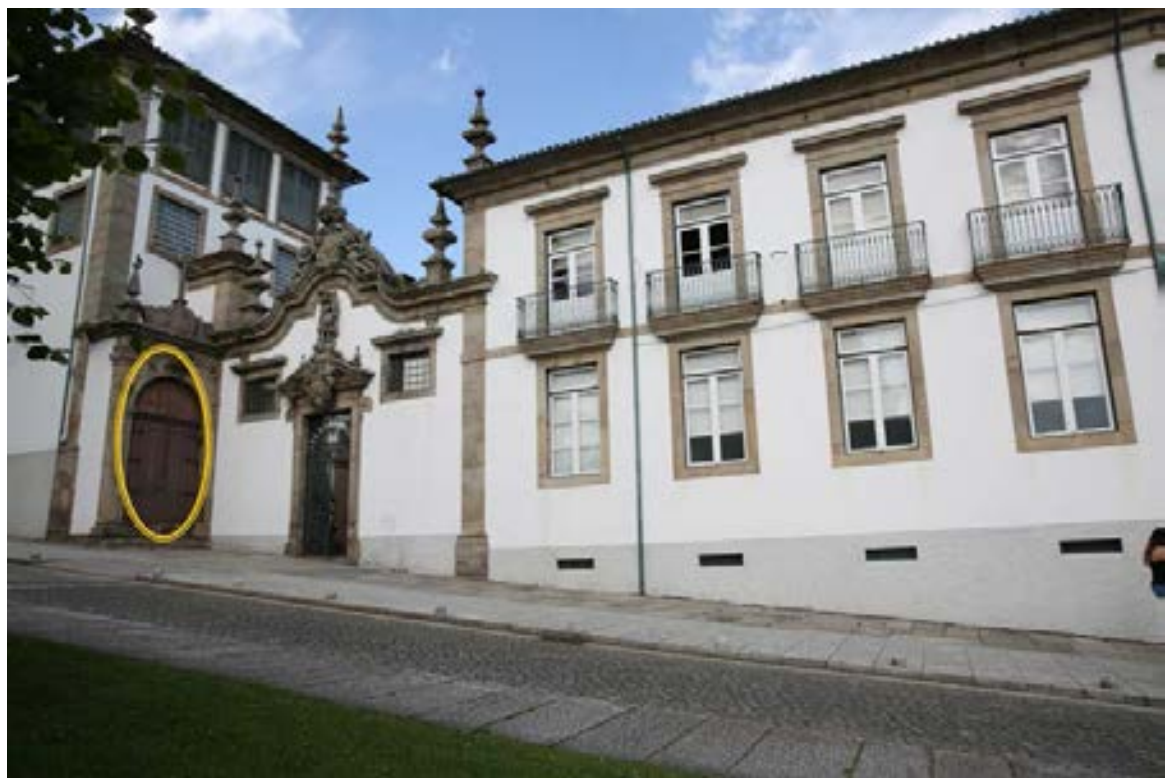
Fig. 31 – Fachada Lateral do Convento com o Oratório destacado. Foto © Afonso Nunes
